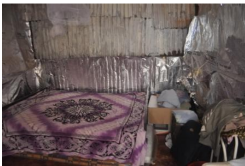
Un « banga » de tôle, habit précaire mais habituel... Les murs ont été isolés avec des feuilles d'aluminium afin de pallier la chaleur insupportable
